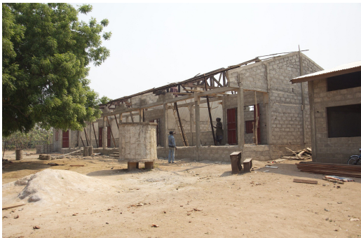
im Bau befindlicher Teil von Block B
